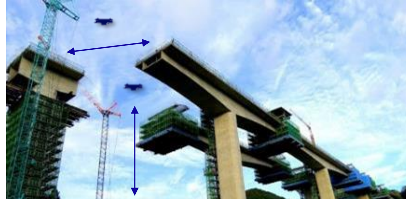
建設現場での資機材の輸送
